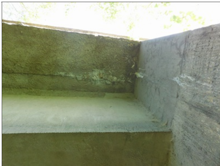
Trhlina s výluhy na podhledu nosné konstrukce vpravo u opěry 2.
