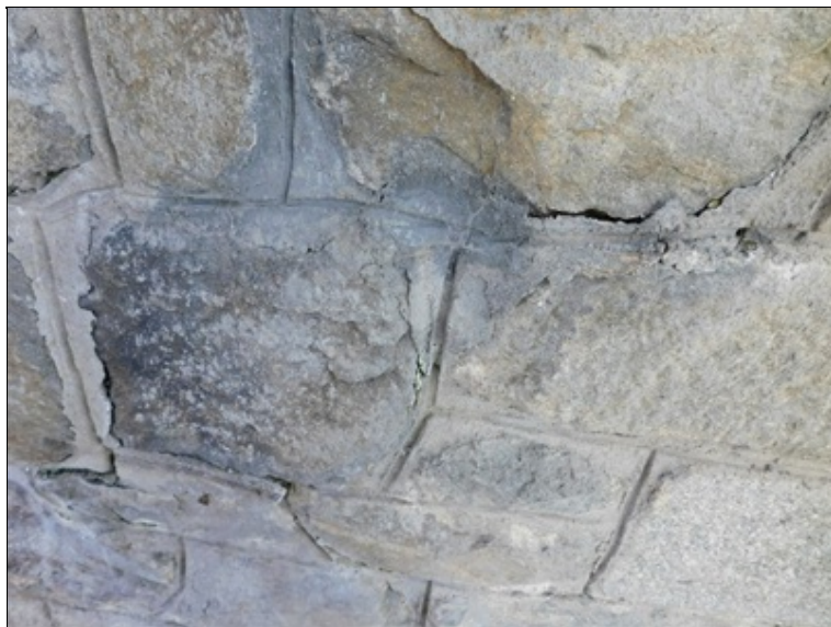
Detail poškozené spárovací malty v opěře.
