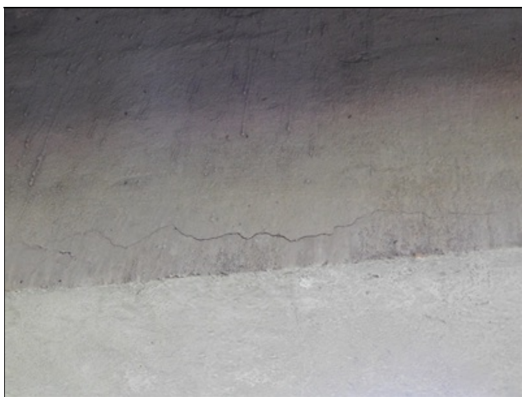
Trhlina na boku levého trámu nosné konstrukce.
