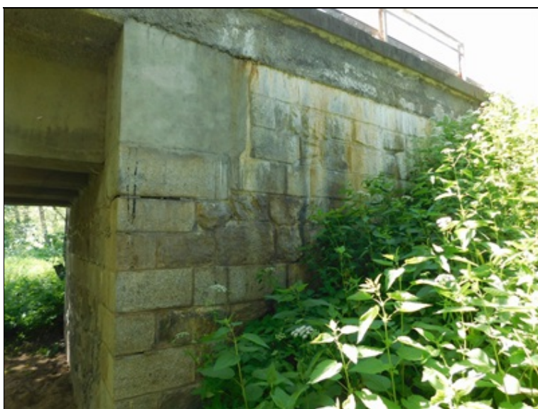
Levé křídlo opěry 1 - zatékání s výluhy.
