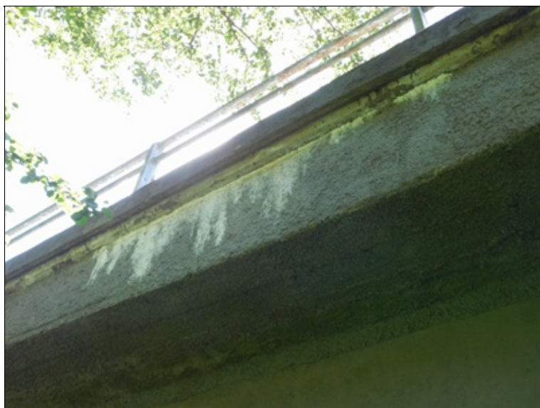
Stopy zatékání s výluhy na bok nosné konstrukce pod římsou (levá strana).
