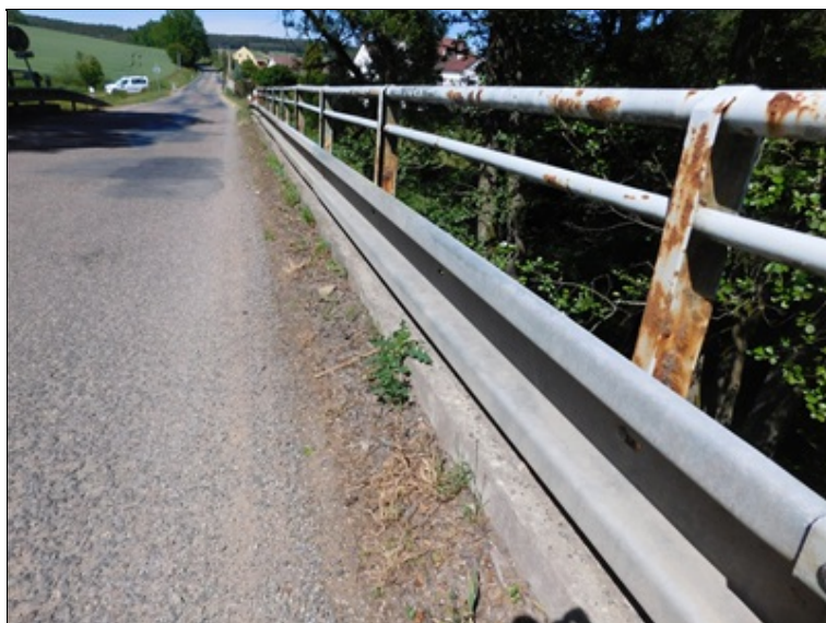
Plošná koroze zábradelního svodidla; nečistoty na vozovce podél římsy.
