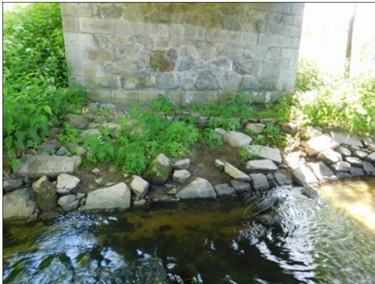
Rozpadlé opevnění břehu řeky.
